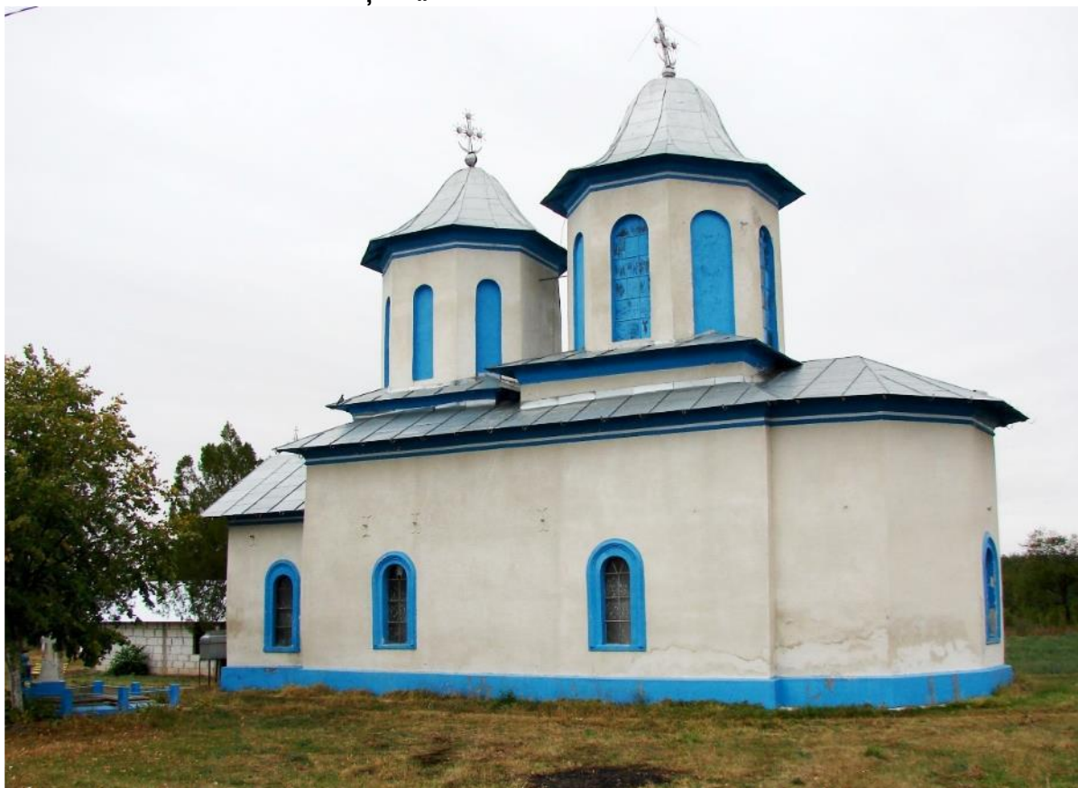
Figură 15 - Biserica Schitului Didești, vedere dinspre sud-est. (Foto, M. Păduraru, 2013).
